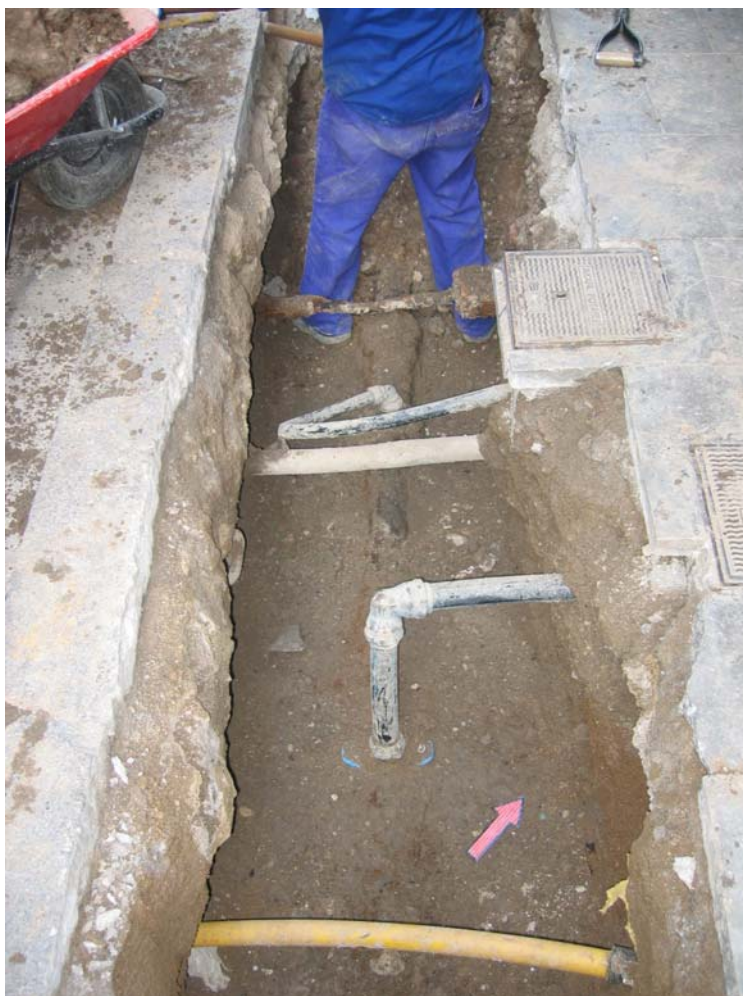
Fotografia 4: Vista des del SE del detall de l'aparició dels serveis subterranis (gas i aigua).
