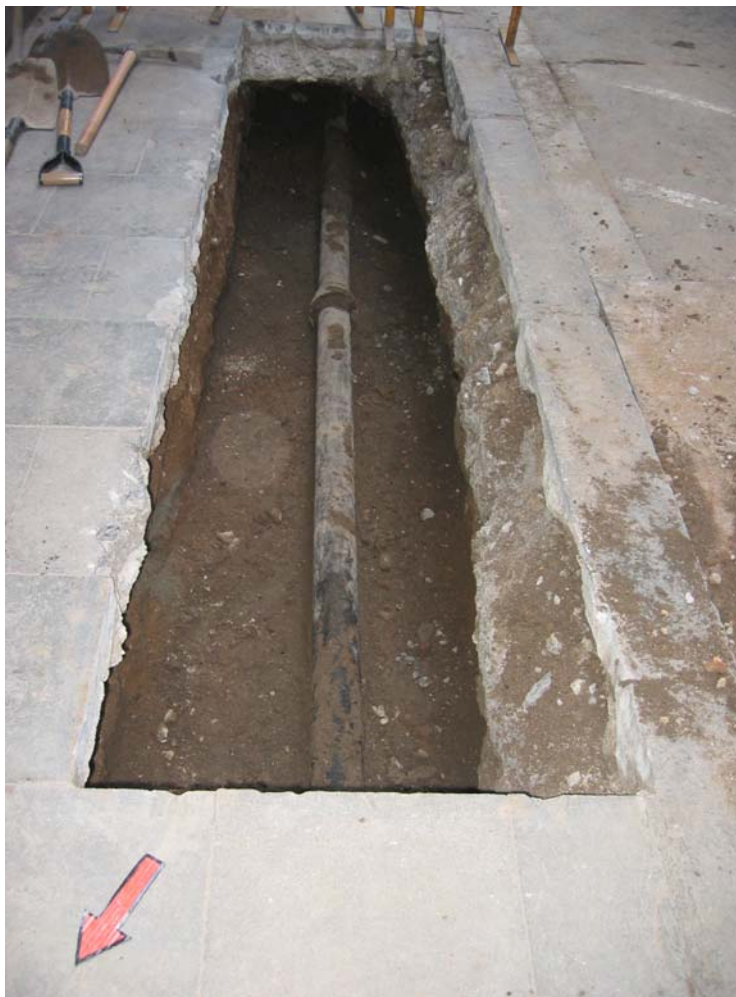
Fotografia 3: Vista de NW a SE d'un tram de la rasa on s'aprecia la coincidència de sentit i direcció de la rasa 100 amb la canonada d'aigua.
