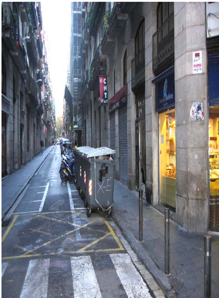
Fotografia 1: Vista general, de sud a nord, del tram del carrer Joaquim Costa, afectat per la intervenció.
